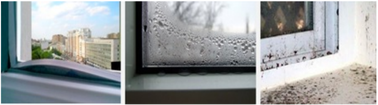
Образование конденсата и плесени на окнах
